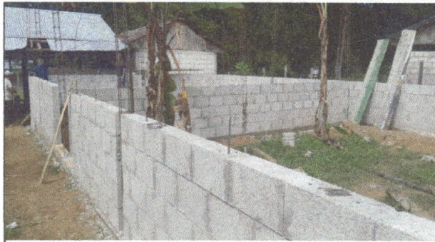
Foto 1: Se observa el levantado de block
