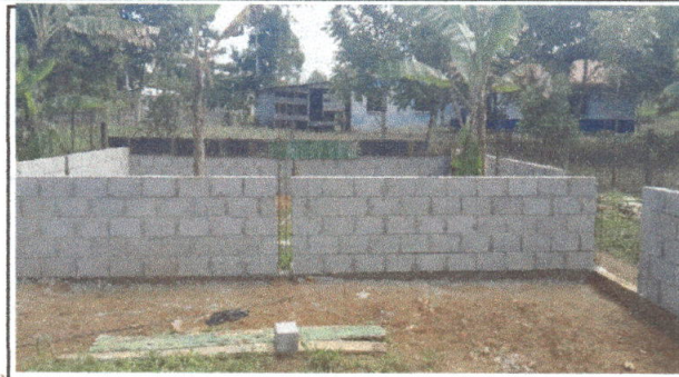
Foto 2: Se observa el avance
